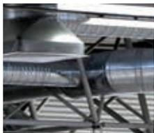
La gamme de produits **BEAMCLAMP** conviennent également pour une utilisation dans le bâtiment des services de l'industrie. Nous avons une variété de solutions pour la connexion de matériel à des structures existantes sans la nécessité de percer ou de souder. Les demandes seraient notamment la connexion des services mécaniques (tuyauterie), la ventilation, chauffage, climatisation, support des fils électriques et de services de protection incendie.
