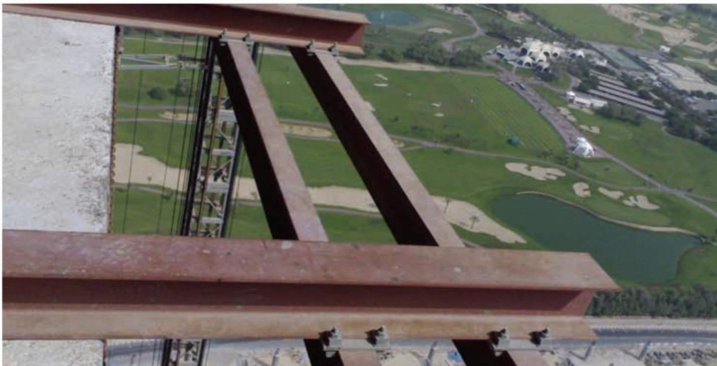
**BEAMCLAMP** est une vaste gamme de produits de fixations, conçus pour l'assemblage de poutres et autres supports de constructions métalliques sans la nécessité de percer ou de souder. Le système de fixation permet au prescripteur d'avoir l'esprit tranquille, d'être certain qu'une fois le raccord effectué il bénéficie d'une charge de travail garantie par un facteur de
