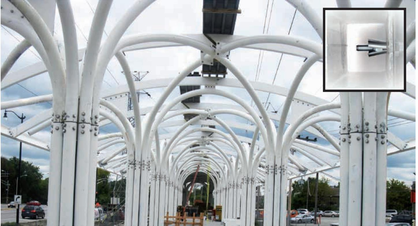
**BOXBOLT** fixations pour sections creuses sont utilisés ici pour joindre un ensemble de tubes. La connection offre un haut coefficient de sécurité et présente un aspect propre à l'extérieur.
