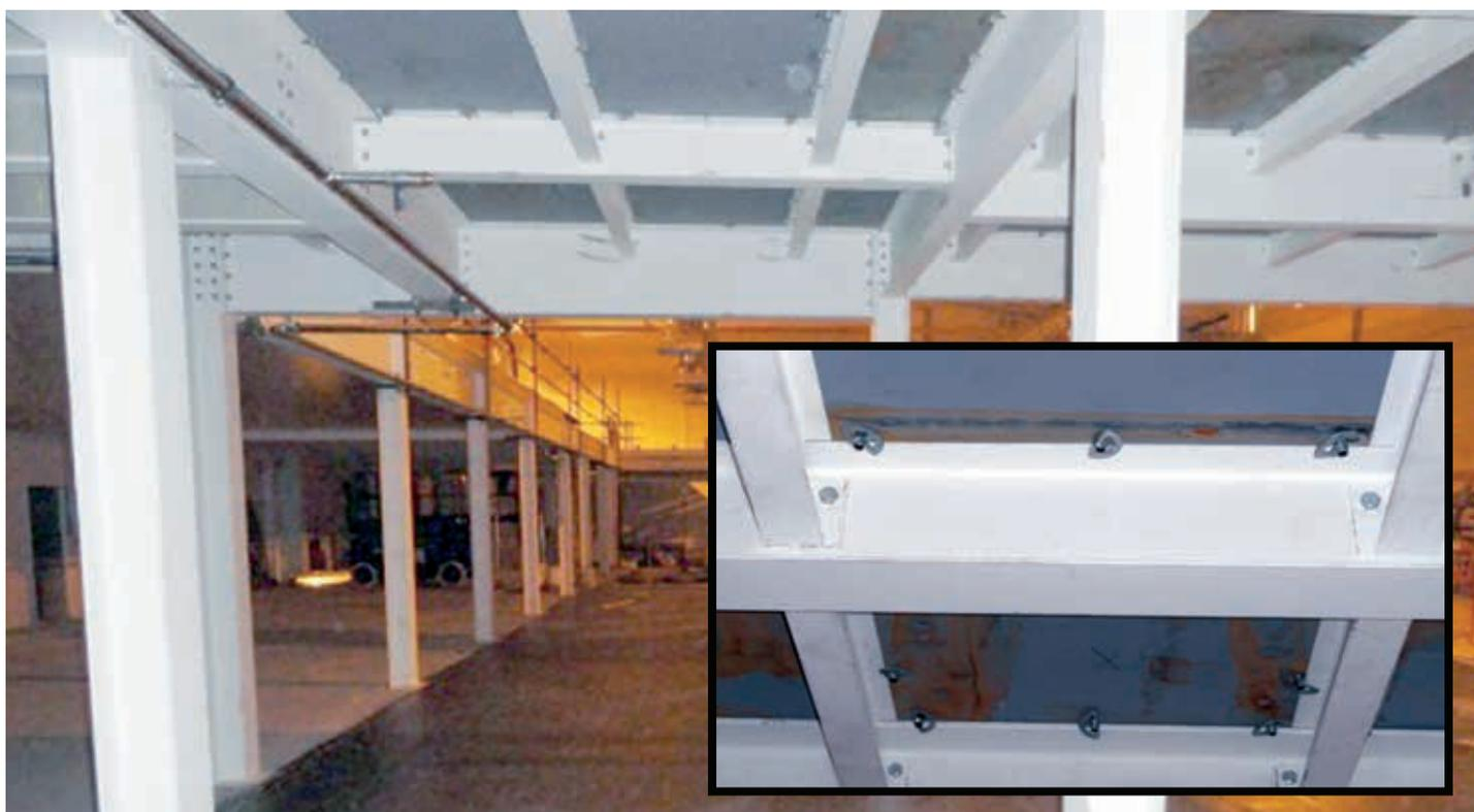
Dans cette applications les fixations pour tôles larmées **FLOORFIX HT** sont utilisées pour fixer l'entre-sol sur la structure en acier. Le montage se fait par le haut seulement et sans avoir besoin de percer, tarauder, boulonner ou souder.
